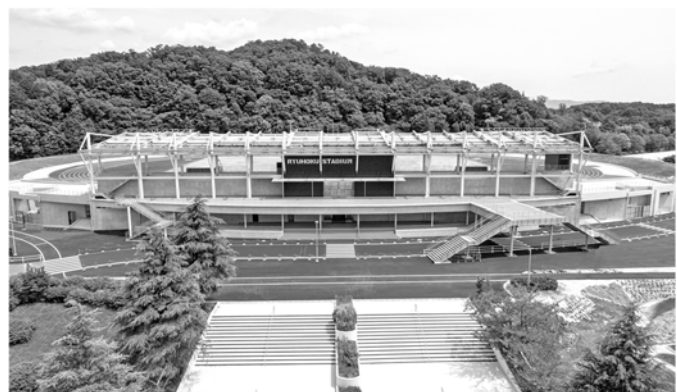
図6 ペデストリアンデッキ（龍北テラス）を備えた新設スタンド
